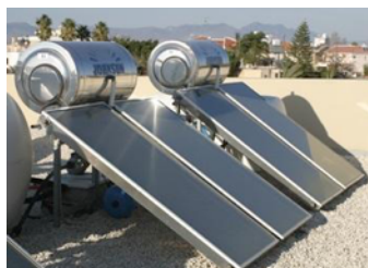
Εικ. 23. Μια οπτική απεικόνιση του συστήματος θέρμανσης με ηλιακό πάνελ (δεξιά) και μια εικόνα ενός ηλιακού πλαισίου που θερμαίνει το νερό στη συνδεδεμένη δεξαμενή πάνω από αυτό, στην Κύπρο (αριστερά) (Πηγή: http://www.3m.co.uk/intl/uk/3Mworld-ly-wise/primary-bldg-southside-6-solar-panel.htm , http://www.solarthermalworld.org/content/cyprus-system-replacements-increase-efficiency )
