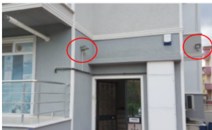
Εικ. 20. Παράδειγμα χρήσης αισθητήρων αυτόματου φωτισμού σε εργαστήριο (Πηγή: Παραχωρήθηκε από συμμετέχον εργαστήριο)
