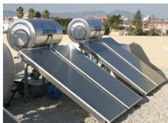
Rys. 25. Wizualne przedstawienie systemu podgrzewania wody za pomocą paneli słonecznych (powyżej) i obraz panelu słonecznego, który podgrzewa wodę w podłączonym zbiorniku nad nim, na Cyprze (poniżej) (Źródło: http://www.3m.co.uk/intl/uk/3Mworldly-wise/primary-bldg-southside-6-solar-panel.htm , http://www.solarthermalworld.org/content/cyprus-system-replacements-increase-efficiency )
