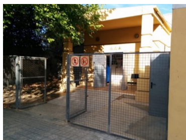
Rys. 14. Przykład kontrolowanego dostępu do składowania odpadów niebezpiecznych (Źródło: otrzymano od laboratorium uczestniczącego w projekcie)
